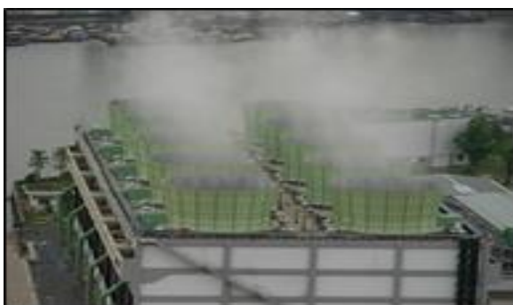
รูปที่ ค-5 การติดตั้งอุปกรณ์ครอบมอเตอร์ขับใบพัด (Cooling Fan Motor) และเพิ่มโครงสร้างเพื่อยึดปล่องใบพัด (Fan Stack) เพื่อลดเสียงที่เกิดจากหอหล่อเย็น
