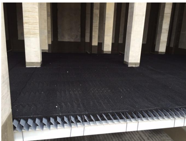
รูปที่ ค-7 การติดตั้งแผ่นดูดซับเสียงบริเวณหอหล่อเย็นของโรงไฟฟ้าพระนครเหนือ
